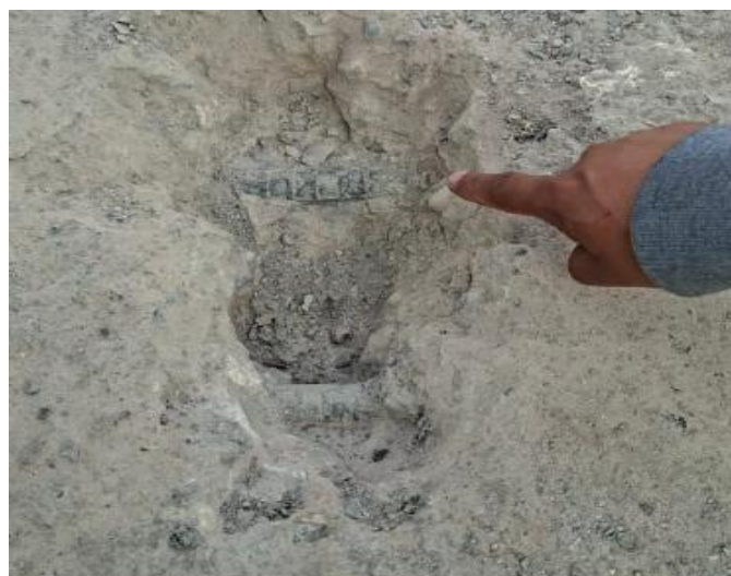
Fotografia 1 Acero superior de viga verificado in situ.
